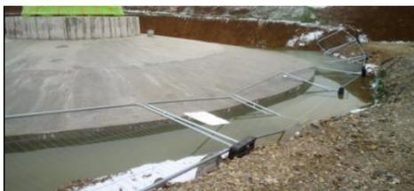
Inondation des fondations d'éolienne à Pressigny (52) (photo « vue imprenable ») et interférence avec un système karstique
